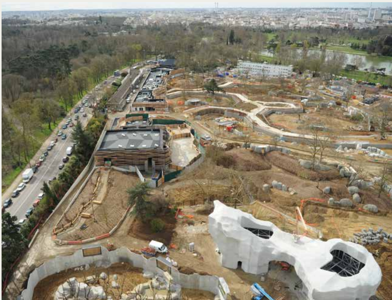
Un chantier impressionnant et technique dans le Parc de Vincennes © Osty et associés, Claude Cieutat
