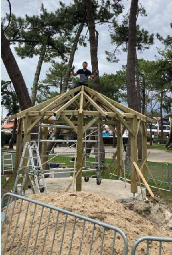
La charpente de la pièce maîtresse, un kiosque octogonal réalisé en pin des Landes
