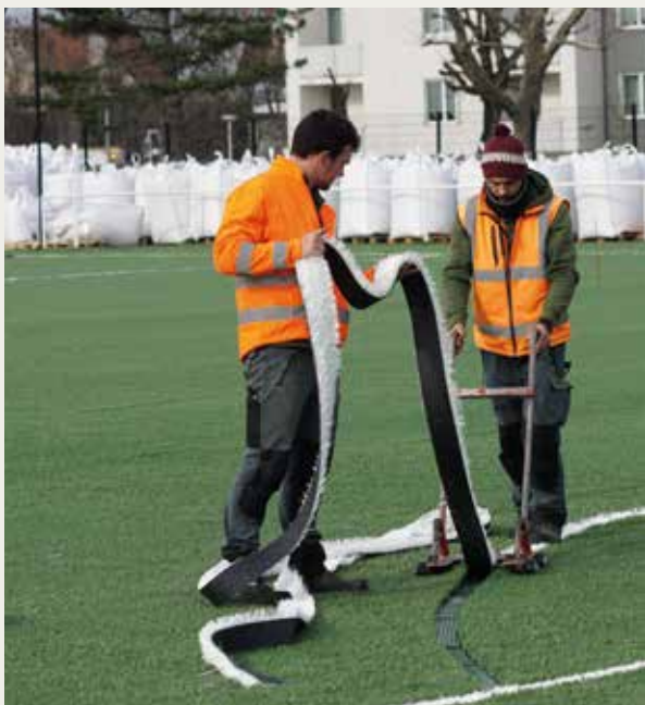
▲ Pose de gazon synthétique pour les terrains de football au Parc du Bourget © Groupe Loiseleur
