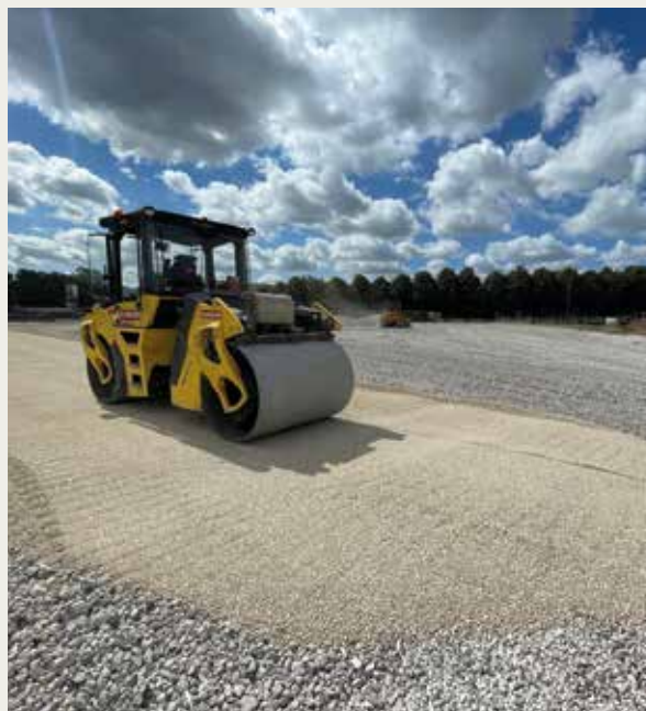
▲ Terrassement des terrains de rugby du Parc de Marville, La Courneuve © Groupe Loiseleur
