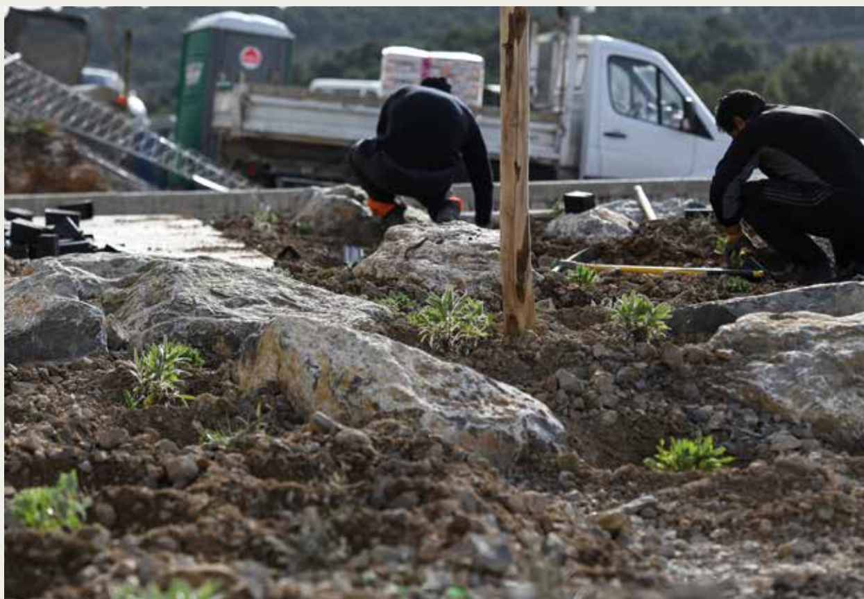
Le sol en place et ses enrochements sont réutilisés © Christian Soulier
