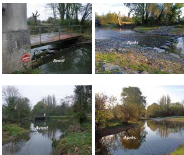
Ouvrage de Terrier © ICEO
