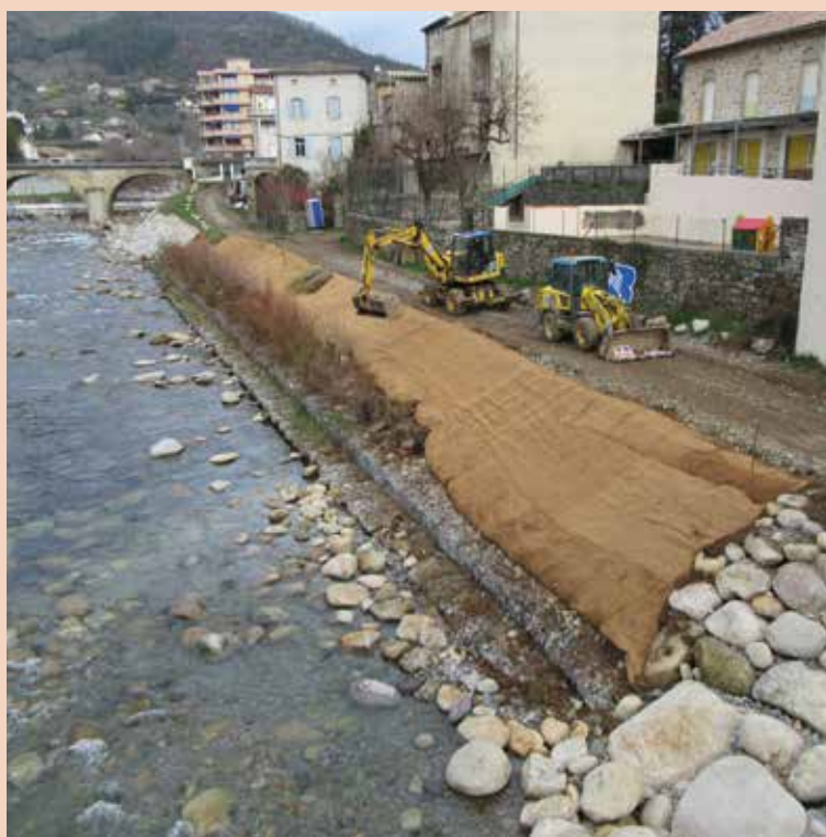
Confortement de berges à Carpentras © Compagnie des Forestiers
