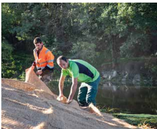
Travaux de restauration du ruisseau de La Boisardière à Divatte-sur-Loire. L'objectif était de redonner une forme « naturelle » à ce cours d'eau tout en permettant l'accès au public.
