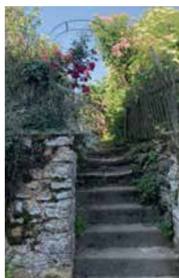
Murs de pierres maçonnées en granit et schiste et Doradille ceterach à Grez-Neuville (49) © Anaïs Nenert
