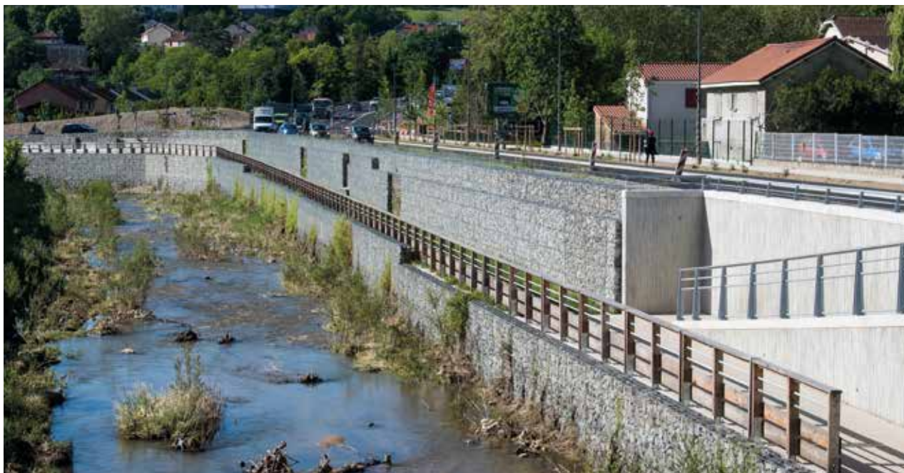
Travaux de protection contre les crues et de restauration environnementale de l'Yzeron à Sainte-Foy-lès-Lyon (réalisation Green Style)
