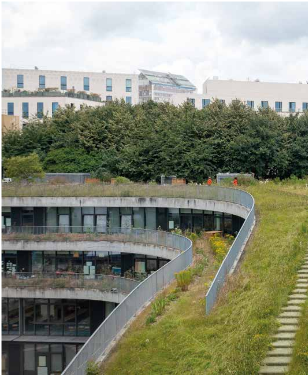
► Le mur d'enceinte de l'école de la biodiversité accueille des nichoirs intégrés à la structure © Yann Monel
