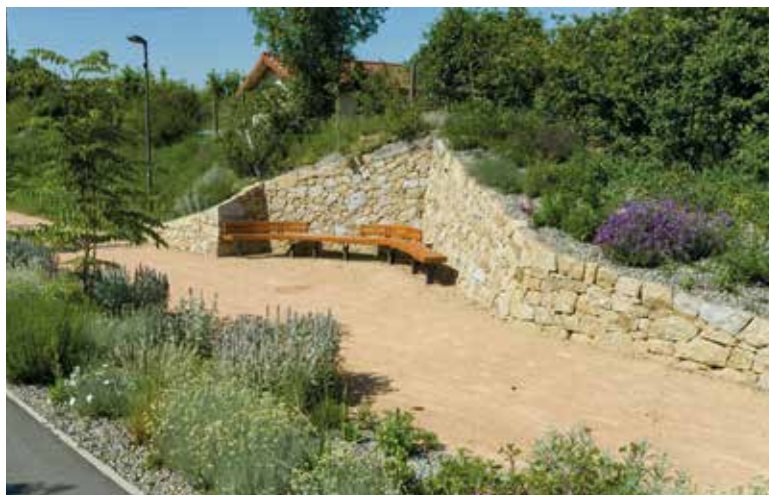
Les murs en pierre sèche, savoir-faire patrimonial, agissent comme régulateurs thermiques
