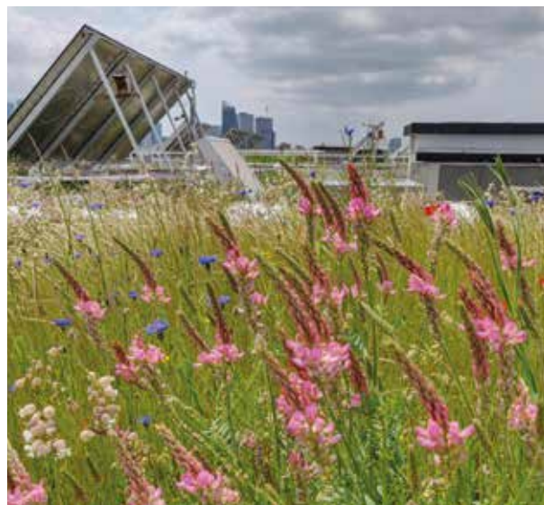
Les toits végétalisés de l'écoquartier Village Delage miment jardin partagé et parties inaccessibles traitées en prairie sauvage © Topager
