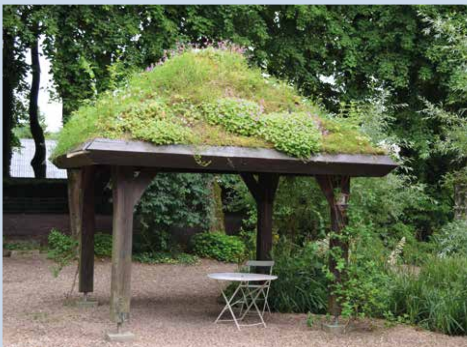
Tonnelle végétalisée en semi-extensif © B. Boudassou
