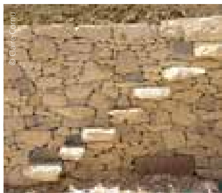
MUR AVEC INCLUSION D'UN ESCALIER
