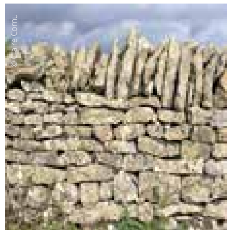
MURET EN AVEYRON
