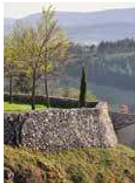
MUR DE SOUTÈNEMENT D'UN JARDIN DANS LE VAUCLUSE
