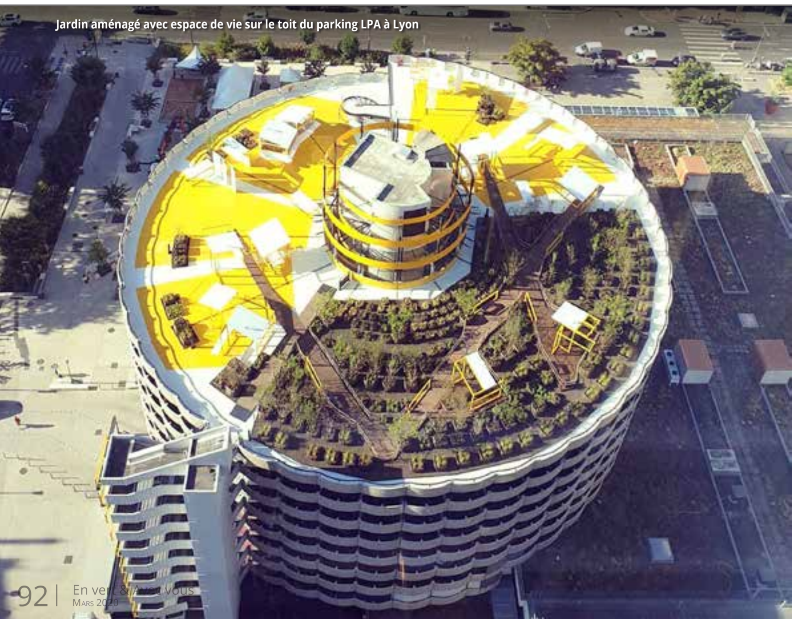
Plantation de stipa tenuissima dans un substrat minéral posé sur toiture
