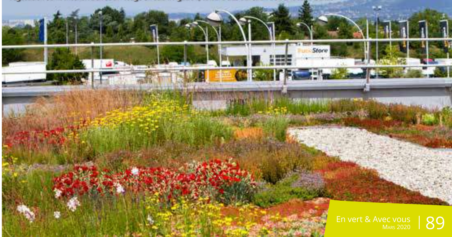
Végétation semi-intensive avec arrosage en sub-irrigation, toiture des bureaux de Terideal à Génas
