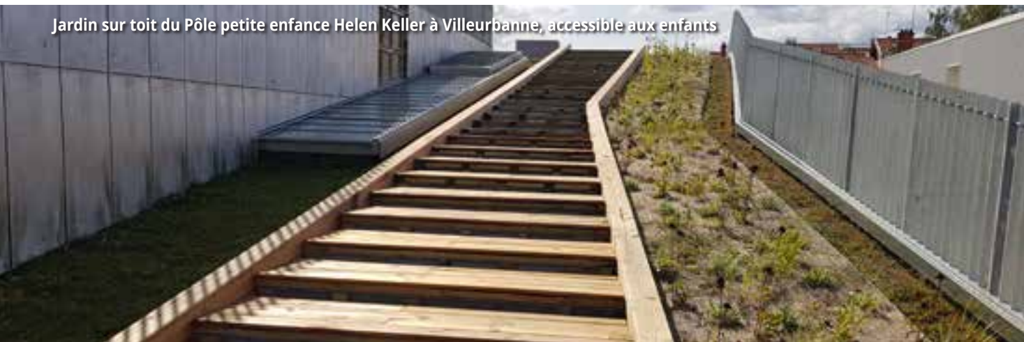
Mise en eau de la toiture-terrace avant intervention de végétalisation
